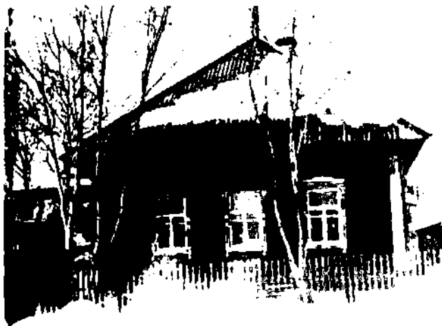
Das Haus von Aron Thiessen in Sewerouralsk, war selberbaute Zimmerwerksarbeit. Die Häuser wirkten klotzig, aber im Winter bei sinkenden Temperaturen bis auf - 45° sogar bis - 50° waren diese Holzbauten doch bedeutend wärmer und gesünder als die Sozialwohnungen aus Stein und Beton.
