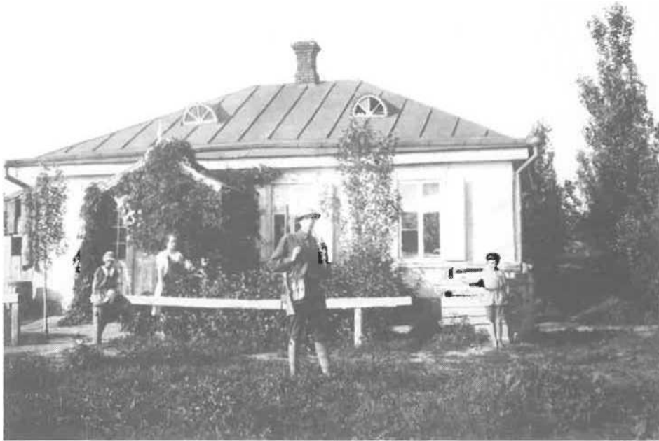
Das Haus des Heinrich Dyck im Waldheim Neuendorf, Baujahr 1921, Aufnahme 1931.
