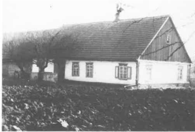
Links das ehemalige Haus von Isaak Ens an der Brücke.
