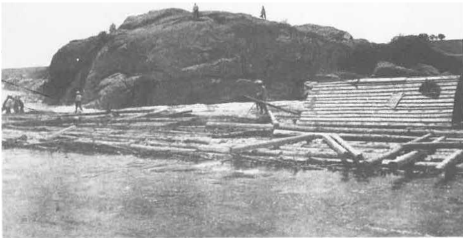
Wir sehen hier ein Floß vor dem Wolfrachen, die engste Stelle wo auch die eiserne Brücke bei Kitschkas gebaut war.
