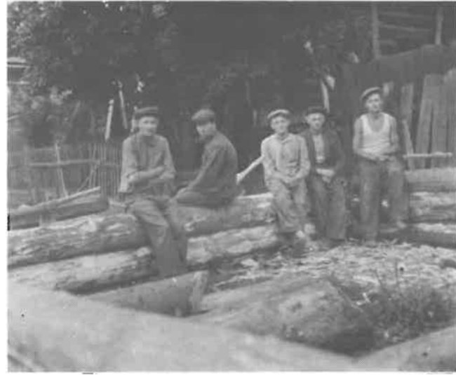
Jakob Klassen, K. Wiebe und andere beim Hausbau.
