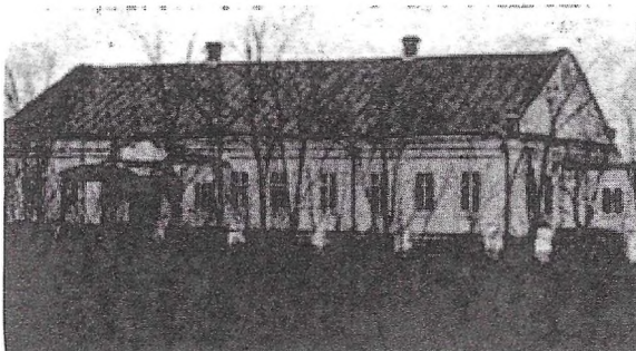
Zentralschule in Neu-Schönsee
