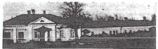
Zentralschule in Grunau
