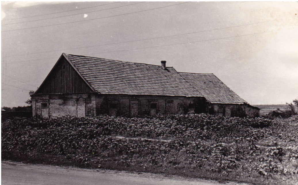
Bild von 1975. Das Haus der ehemaligen Wirtschaft N 18 in Ohrloff.
