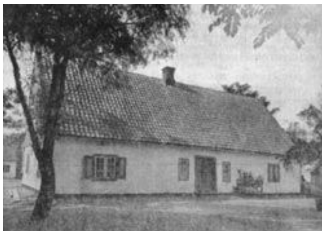
Erstes Halbstädter Zentralschulgebäude, erbaut 1835
